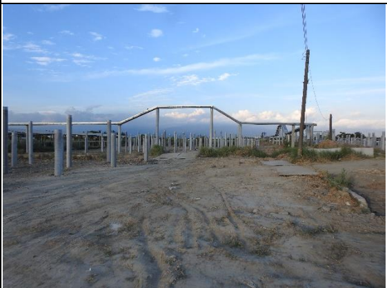
鎮安濕地北側設置光電板施工中
