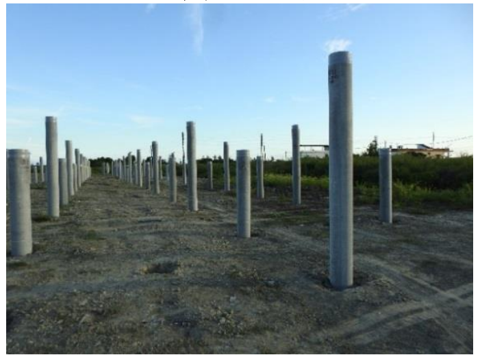
鎮安濕地北側設置光電板施工中
