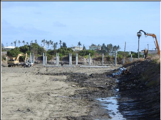
光電板水泥基樁施工中
