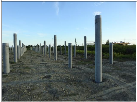
鎮安濕地北側設置光電板施工中
