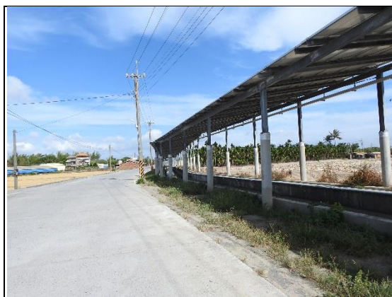
排水溝渠上設置光電板
